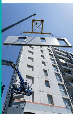
2024 est l'année du chantier Bel Air. Les travaux ont d'abord débuté dans les logements, puis se sont poursuivis par l'isolation extérieure, avec comme particularité la préfabrication en usine de 40 % des façades selon la méthode "EnergieSprong Compatible". Cette méthode présente l'avantage de réhabiliter 930 logements en seulement 20 mois ! Elle réduit
